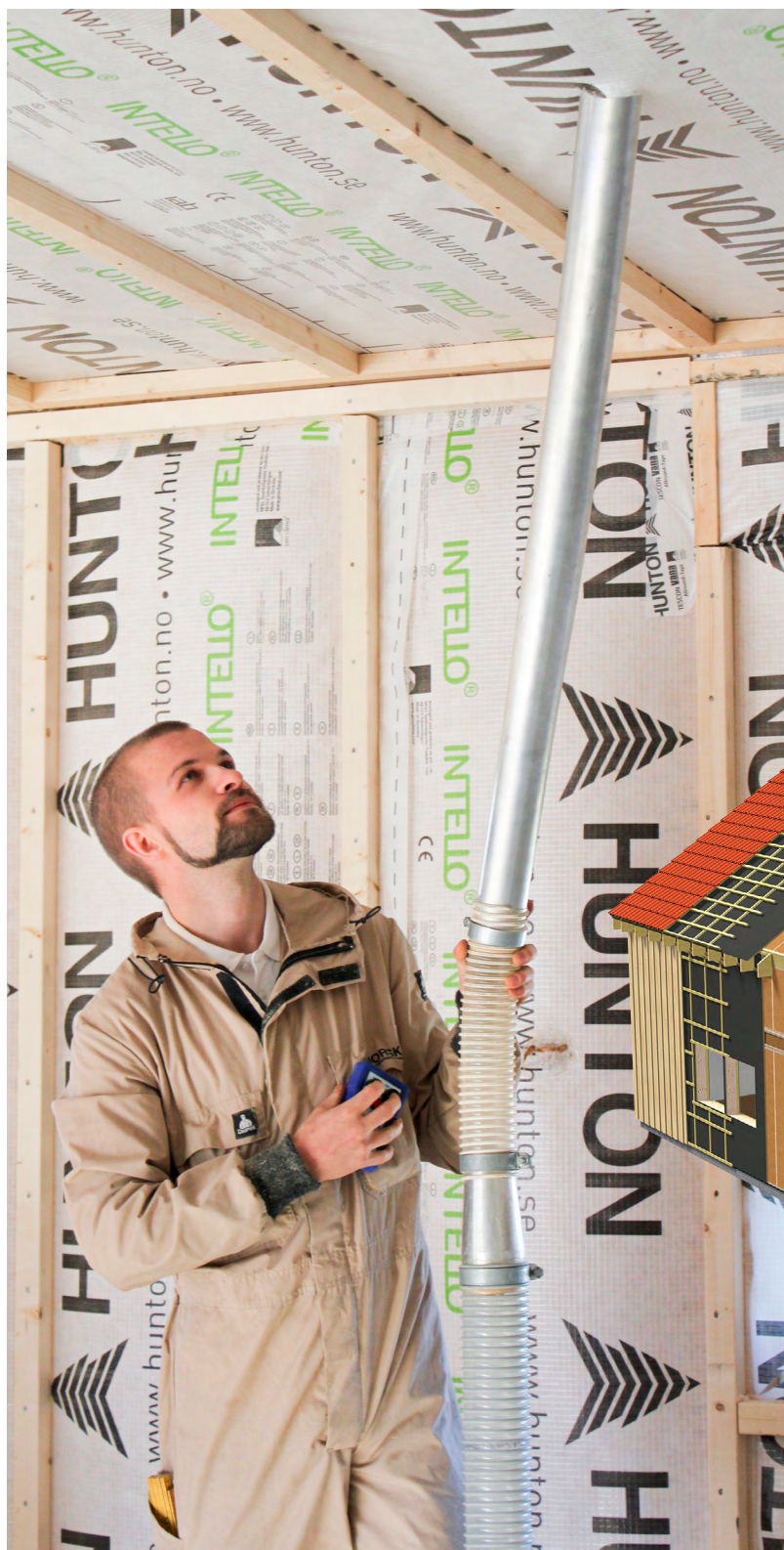
Illustrationen viser en væg blæseisoleret med Nativo Træfiberisolering.
